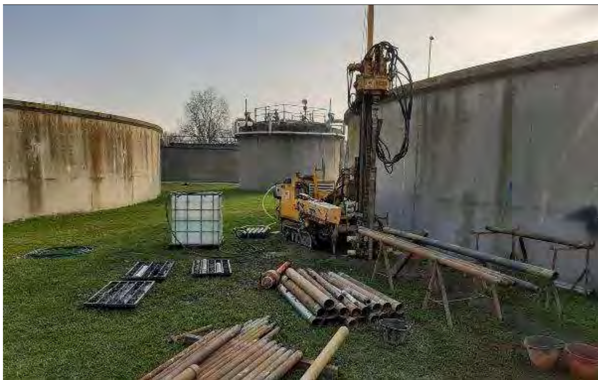
Figura 9. Piazzamento sondaggio S2
