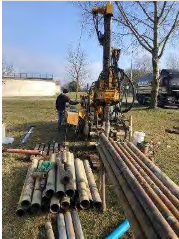
Figura 17. Piazzamento sondaggio S3 (sinistra) ed esecuzione prova Lefranc (destra)
