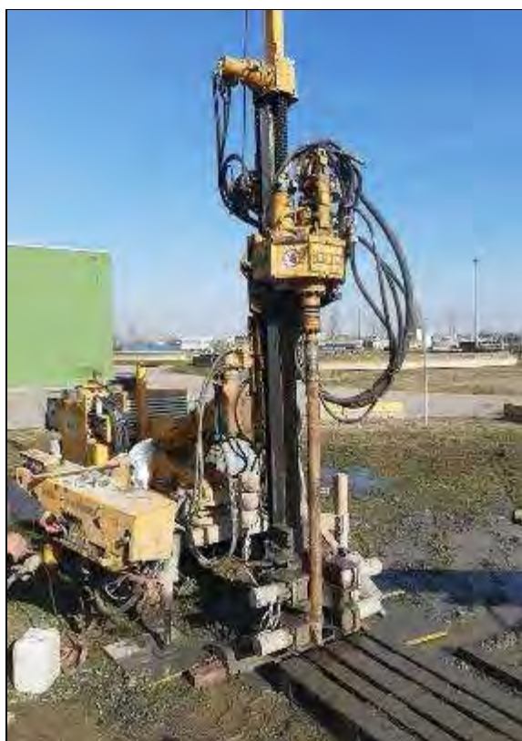
Figura 34. Piazzamento sondaggio S5 (sinistra) e piezometro finito (destra)
